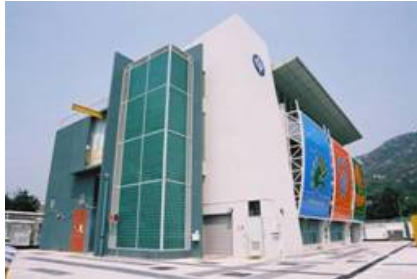
So Kwun Wat Substation
