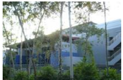
Mai Po Substation
